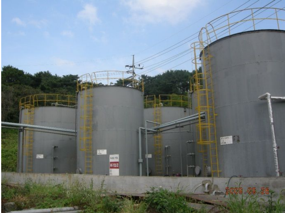
Figura 1-9: Tanques de armazenamento de combustível para geração de energia por motores a combustão ou turbinas ligadas a geradores elétricos (Landfill Mitigation Solutions).
